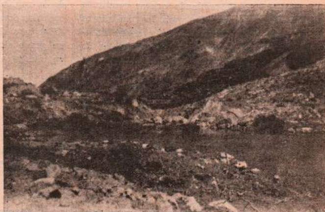
Vista del derrumbe que relleno la quebrada, estancando el agua del río. — Se nota la boca de salida que formó el agua.
