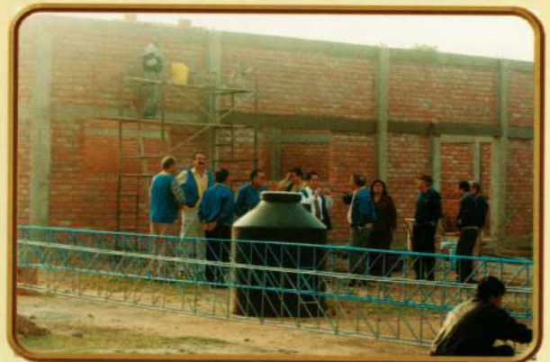
Amigos Rotarios supervisando la Obra
