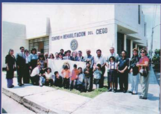
Centro de Rehabilitación del Ciego remodelado y en proceso de ampliación y equipamiento por sistema computarizado Braille. Obra Centenario Rotary Club de Chiclayo
