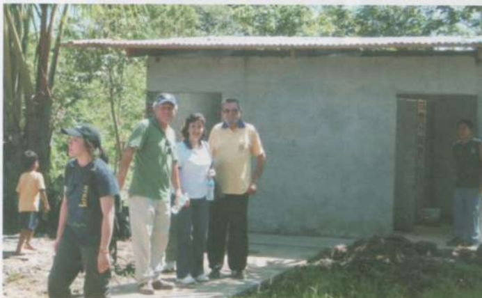
Rotarios Carlos Acosta, Violeta Vigo y Carlos Chávez durante la visita de inspección. Detrás de ellos se aprecian los baños que se construyen gracias al MG#67984
