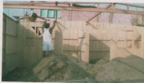
Instalación del nuevo local
